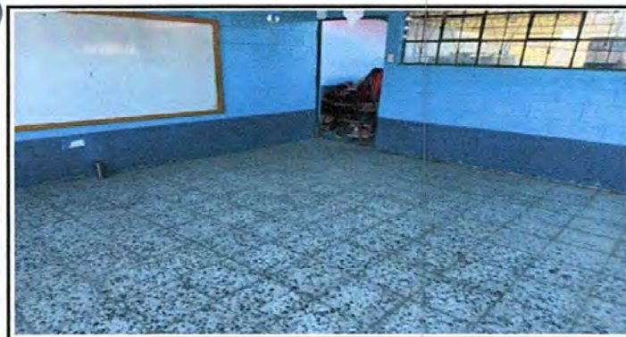
Foto 11: Piso de granito y pintura dentro de las aulas.
