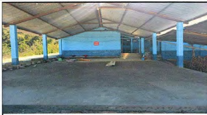
Foto 8: Losa de patio principal.
