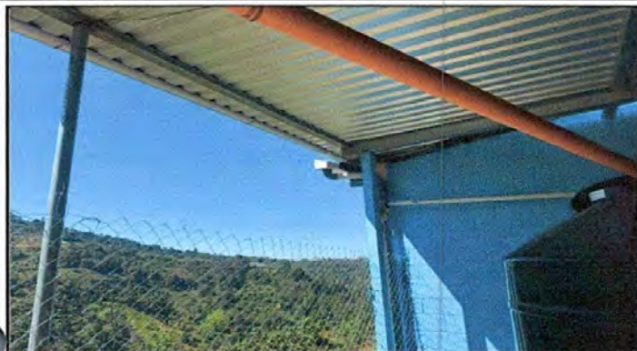
Foto 7: Canales y bajadas de agua pluvial
