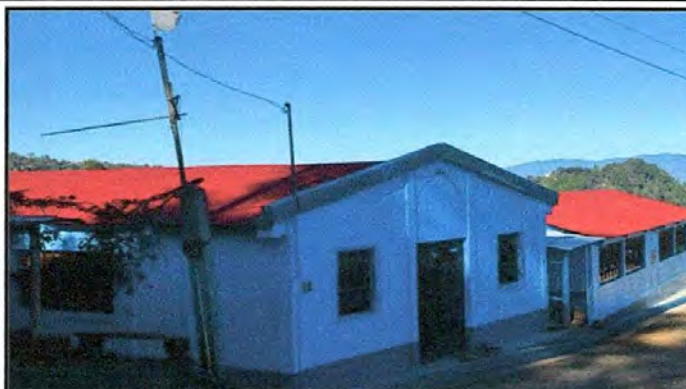
Foto 2: Cubierta de lámina del establecimiento.
